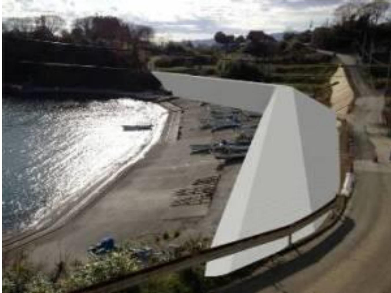
津波対策用防潮堤
